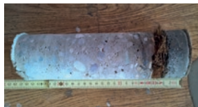
Stahlbetonzwischendecke mit teerhaltigem Asphaltbelag auf Trittschalldämmung aus Kokoswolle
