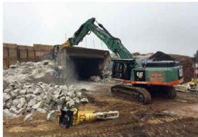
Kernaufgabe des neuen Arbeitsgeräts ist der Brückenabbruch, der ein Drittel des Abbruchumsatzes ausmacht. Foto: Max Wild
