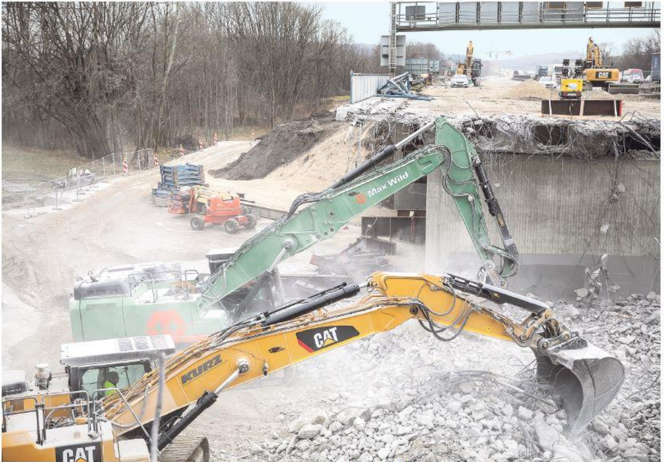
AUSGERÜSTET MIT mit Abbruchzangen, Greifern und Hydraulikmeißeln startete die Caterpillar-Flotte den Abbruch des Brückenbauwerks bei Ismaning an der Münchener Straße. Mittels Hydraulikmeißeln wurde der Überbau zunächst perforiert und anschließend mit Hydraulikzangen sukzessive gemäß Abbruchplänen rückgebaut. Der Abbruch verlief reibungslos, planmäßig und ohne Zwischenfälle. Insgesamt 750 m 3 Stahlbeton landeten im letzten Schritt auf der Ladefläche der Dumper. Vor Ort wurde der Stahlbeton pulverisiert. Schließlich sollte alles soweit wie möglich einer Wiederverwendung zugeführt werden. Lesen Sie dazu auch unseren Bericht „Neun Brücken...“ auf Seite 11. PHOTO: MAX WILD
