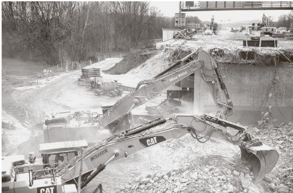
Die Abbrucharbeiten an der Autobahn 99 nahe München verliefen trotz einiger Unwägbarkeiten durchweg problemlos.
