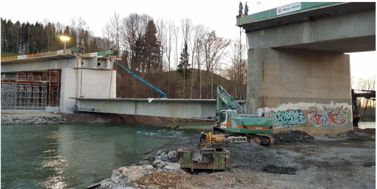
Am 14. April wurde das mittlere Brückensegment abgesetzt. (Foto: Ulrich Weigel)
