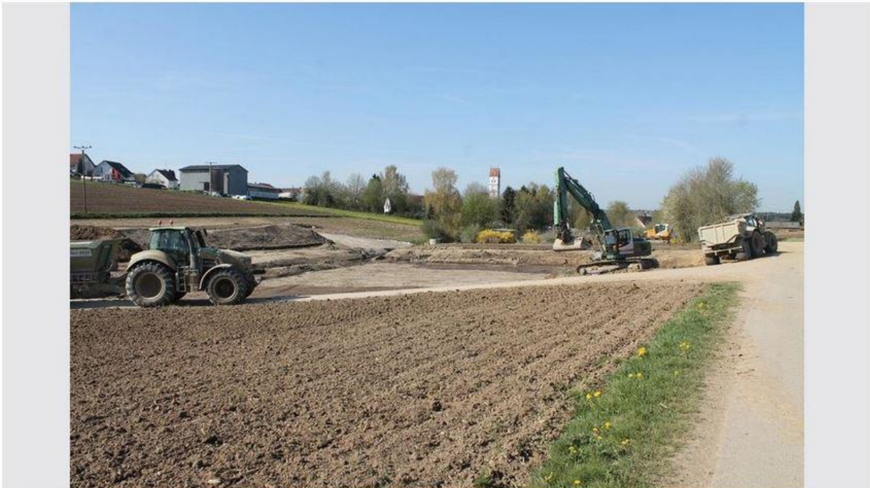
Der Ausbau des Rückhaltebeckens „Rotbächle“ schreitet voran. (Foto: Kurt Kiechle)
