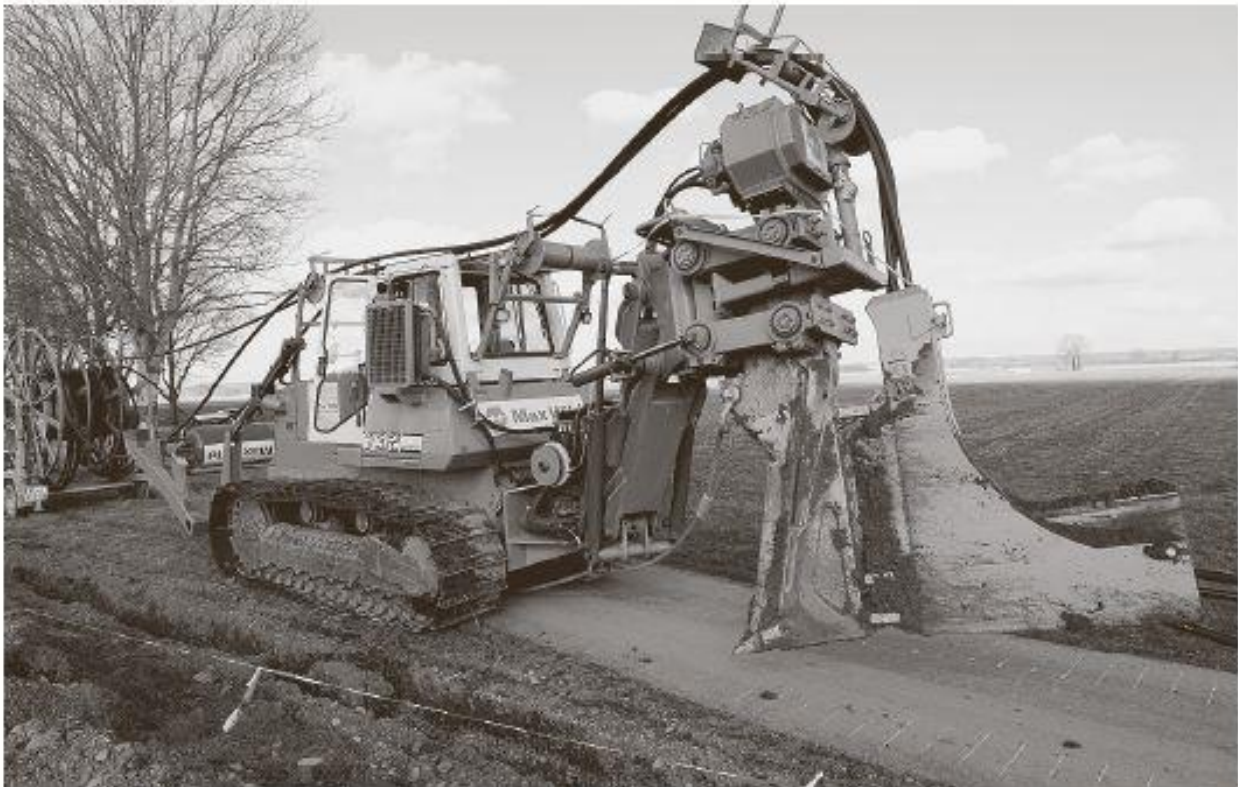
In gemächlichem Schrittempo arbeitet sich der Kabelpflug Meter für Meter nach vorne. Mehr als 20 t wiegt der Koloss und hinterlässt trotz seiner mächtigen Erscheinung kaum Spuren.
