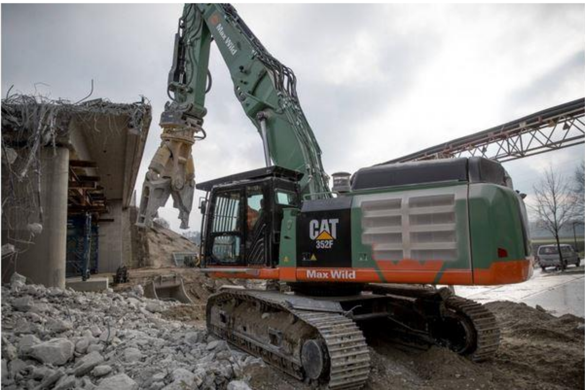
Ein Cat 352F von Max Wild bei Abbrucharbeiten an der A99
