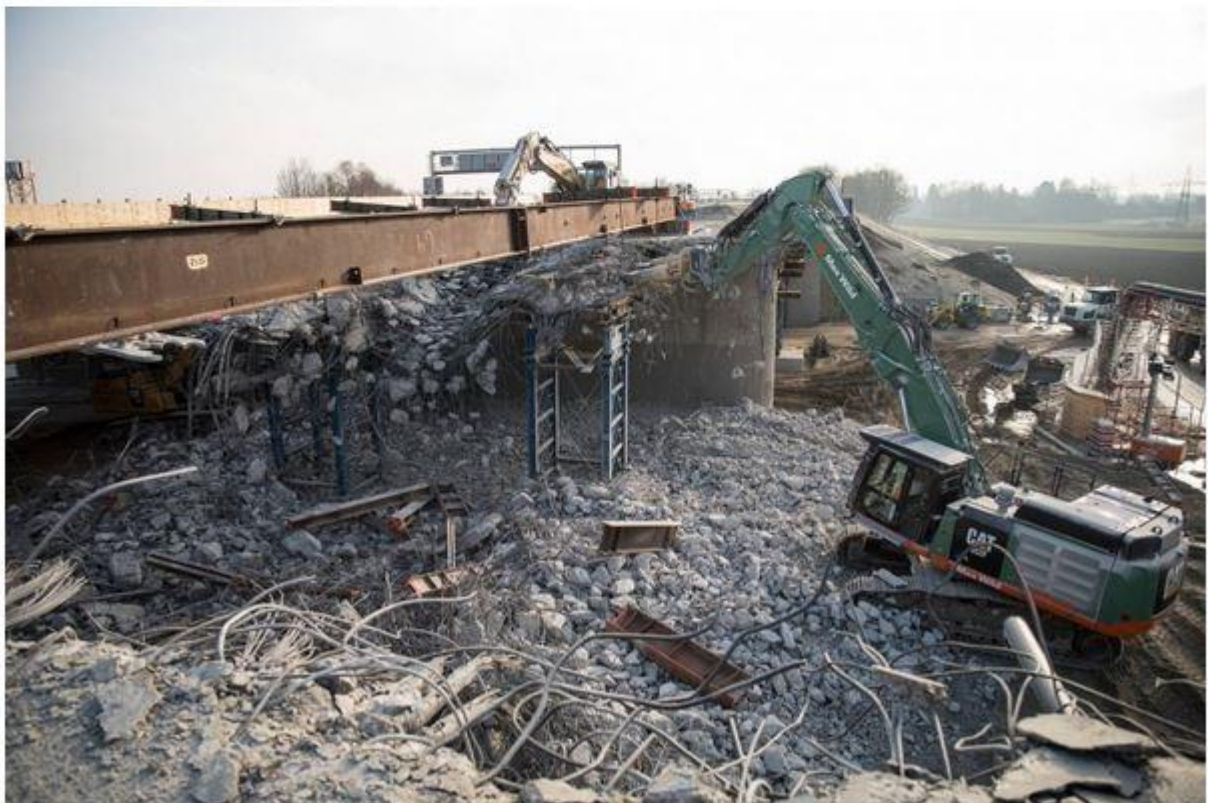
Das Megaprojekt an der A99 umfasst den Abbruch von insgesamt 9 Bauwerken
