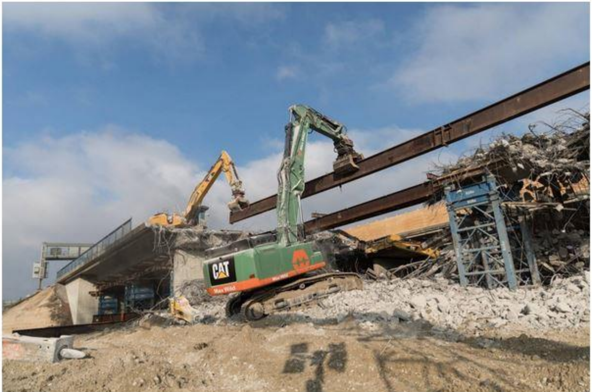
6 Brücken wurden bereits abgerissen, 3 sollen noch folgen
