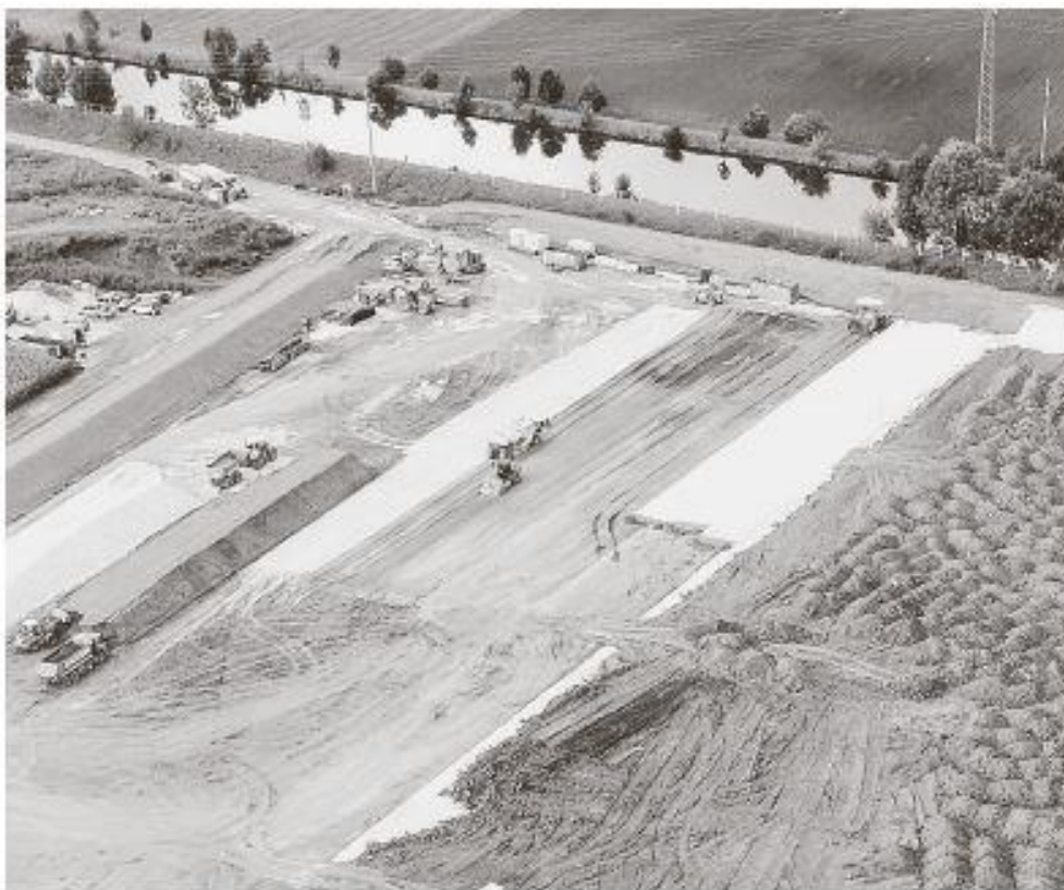
Der Flutpolder am Donaukanal ist fast fertig.
