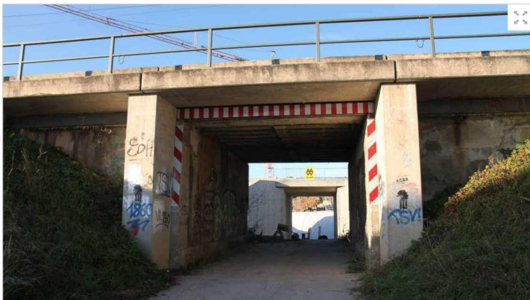
Vorne alt hinten neu: Wunsch der Gemeinde war es, die einspurige Unterführung mit weitgehend identischen Maßen zu bauen. Für den ÖPNV-Bus reicht es für den LKW-Schwerverkehr nicht. © Kronenbitter
