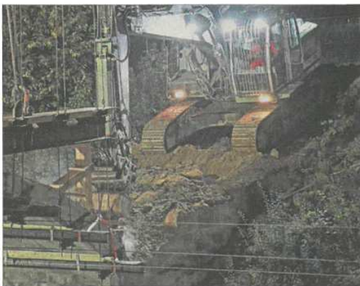
Bis die Brücken abgerissen werden konnten, waren aufwendige Vorbereitungen notwendig.
