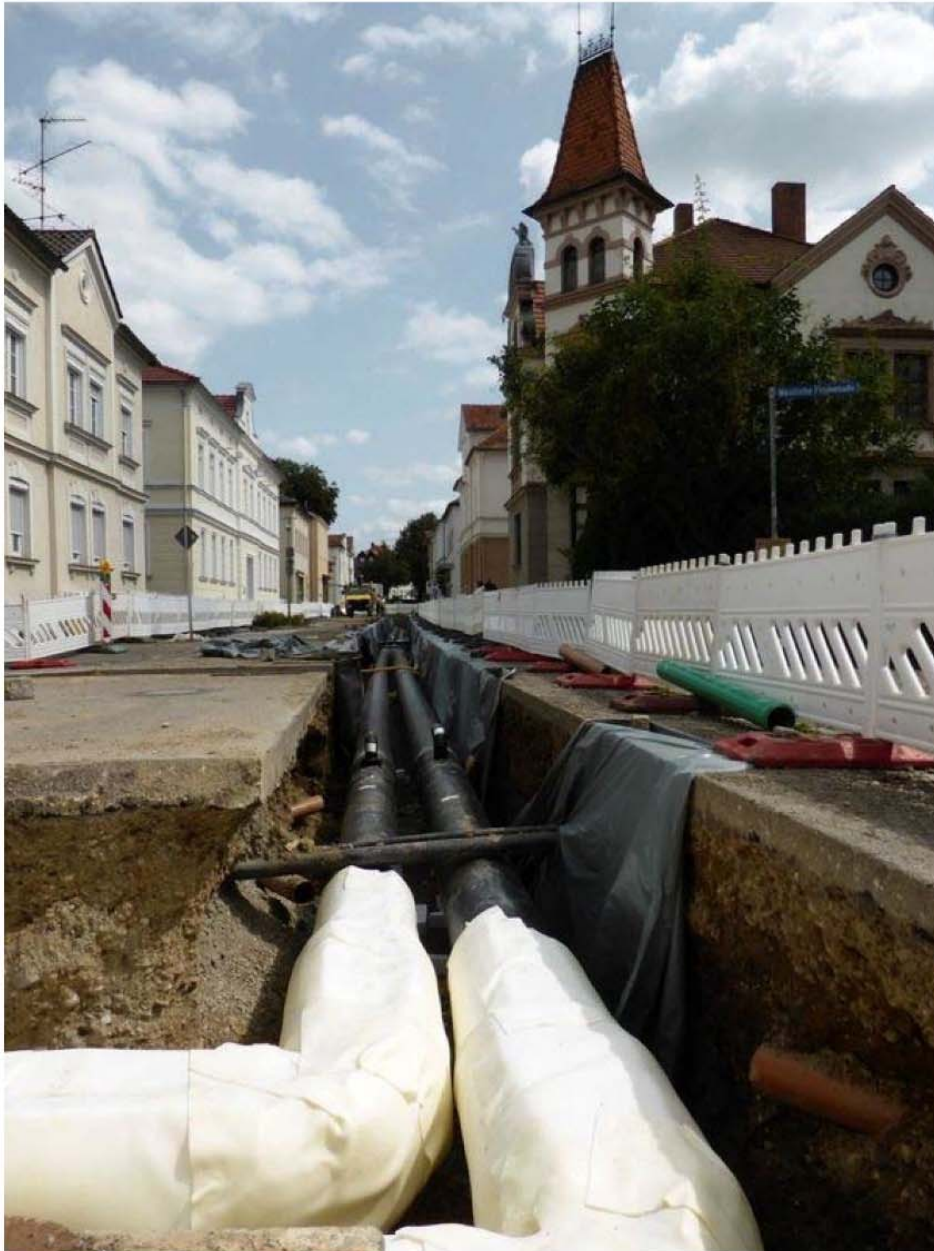
Der Bau der Fernwärmeleitung schreitet in Weißenhorn voran. Derzeit werden Leitungen in der Bahnhofstraße verlegt. Fotograf: Claudia Schäfer
